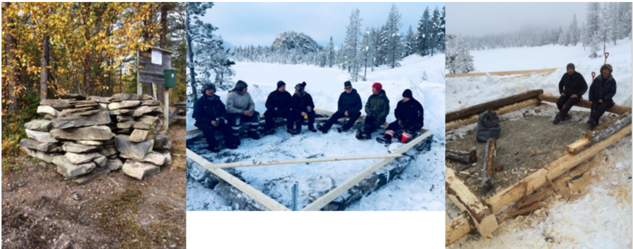
Med sten fra Søstu Messelt bygde vi ny grunnmur i januar før vi startet opp med flytting og nye stokker i vinterferien. Knalldugnader der resultatet ble helt topp. Nå på Solsiden av Brennkrok .
